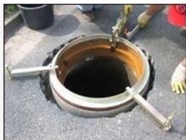
po 20 minutach zakładamy pierścień pokrywowy
