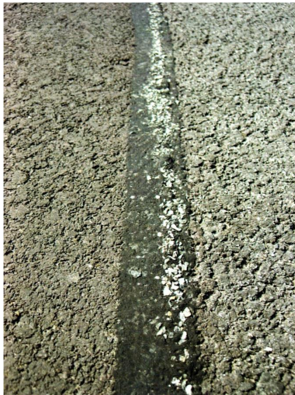
Rys. 4. Wykonanie złącza podłużnego metodą „gorące przy zimnym” bez zastosowania materiału uszczelniającego złącze, np. bez taśmy topliwej (Sposób niezalecany na drogach publicznych. Może być stosowany tylko wyjątkowo za zgodą Inżyniera, np. na krótkich odcinkach lub w warunkach specjalnych)
