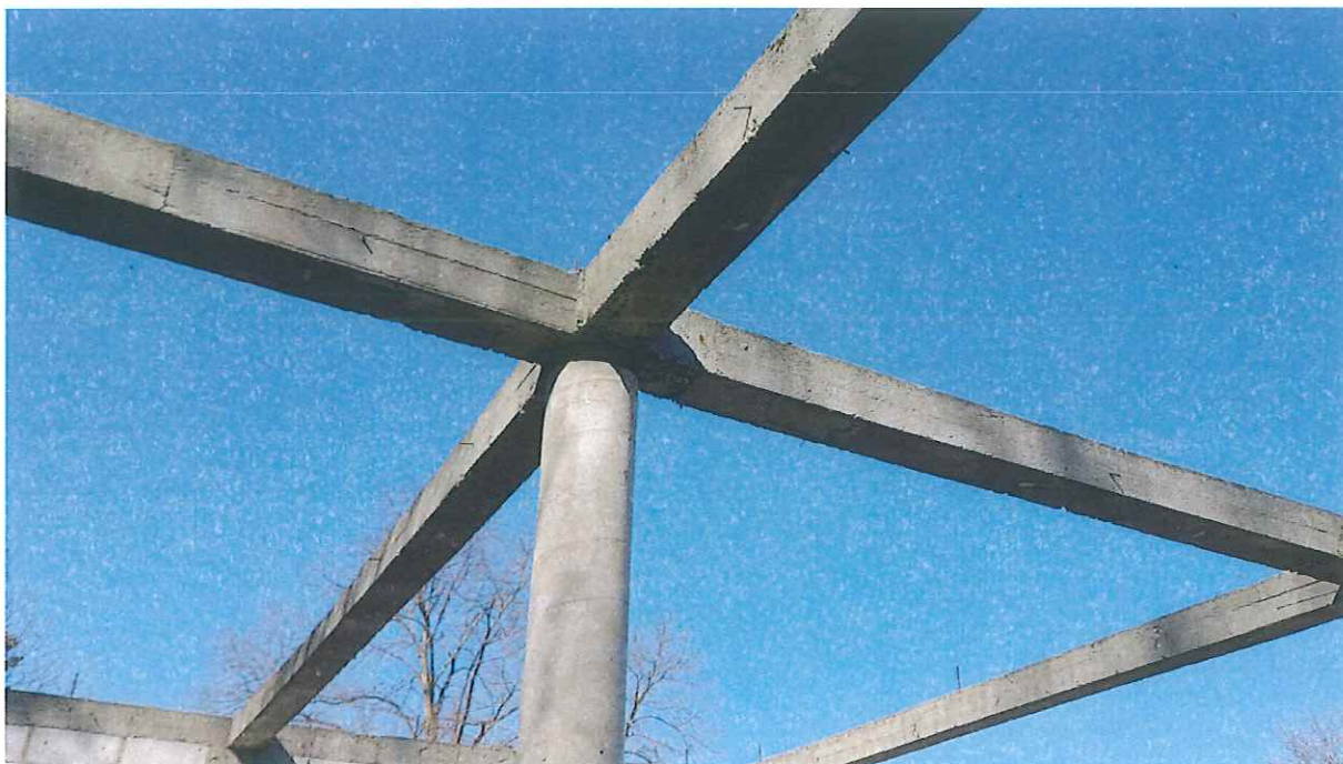
foto nr 2. Widok połączenia słupa z podciągami
