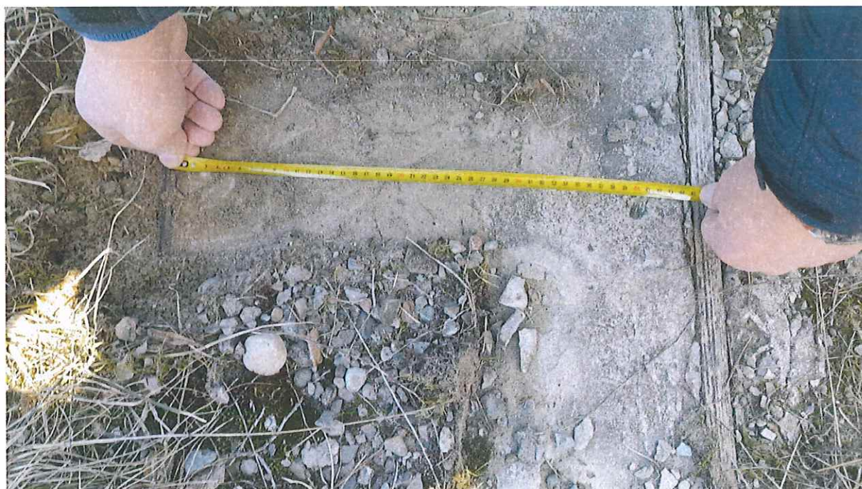
foto nr 5. Widok ławy i ściany fundamentowej w bramie
