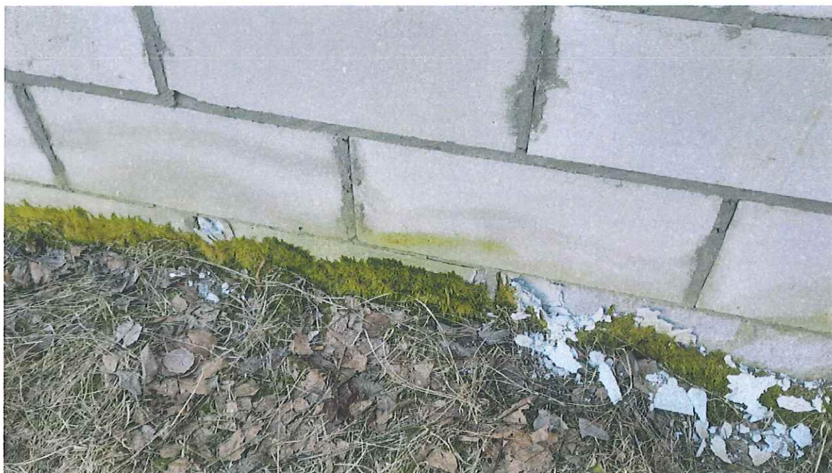
foto nr 8. Zawilgocenie ściany parteru.
